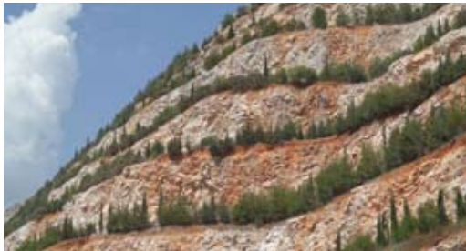
Αποκατάσταση του λατομείου Δρυμού του ΤΙΤΑΝΑ.
