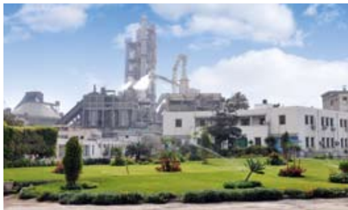
Το εργοστάσιο της Alexandria Portland Cement Co. στην Αίγυπτο.
