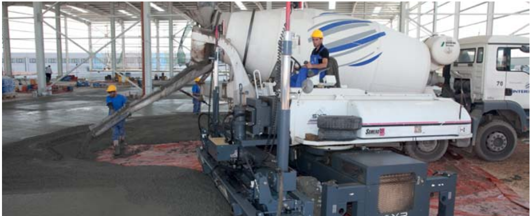
Εκφόρτωση του INTERSTEEL στο χώρο διάστρωσης απευθείας από το αυτοκίνητο-αναμικτήρα.
