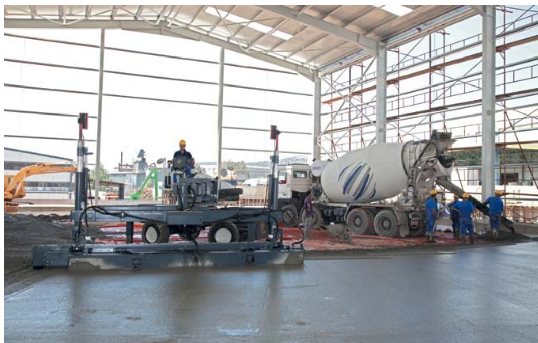
Διάστρωση του INTERSTEEL με ειδικό μηχάνημα που ρυθμίζει αυτόματα την επιπεδότητα του δαπέδου (laser screed).
