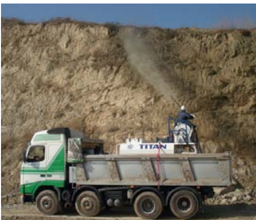
Αποκατάσταση λατομείου με τη μέθοδο της υδροσποράς στο Usje (ΠΓΔΜ).
