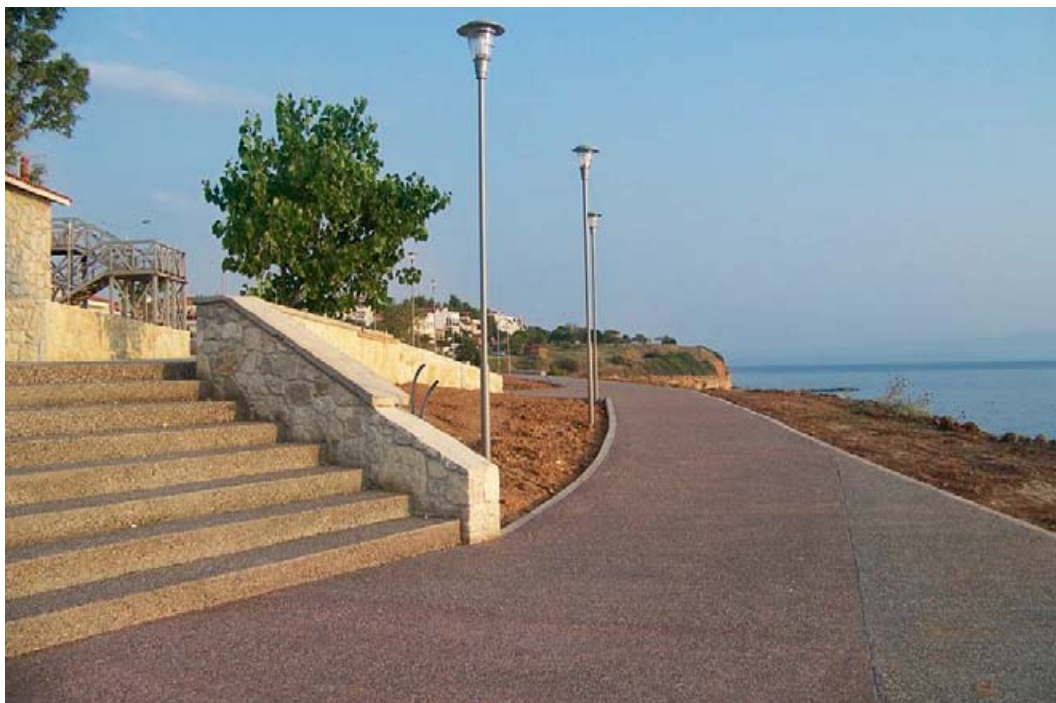
Πεζόδρομος και σκαλοπάτια που κατασκευάστηκαν με INTERTOP σε κόκκινη απόχρωση και συμβατική φαιά, στην παραλία της Νέας Φώκαιας.
