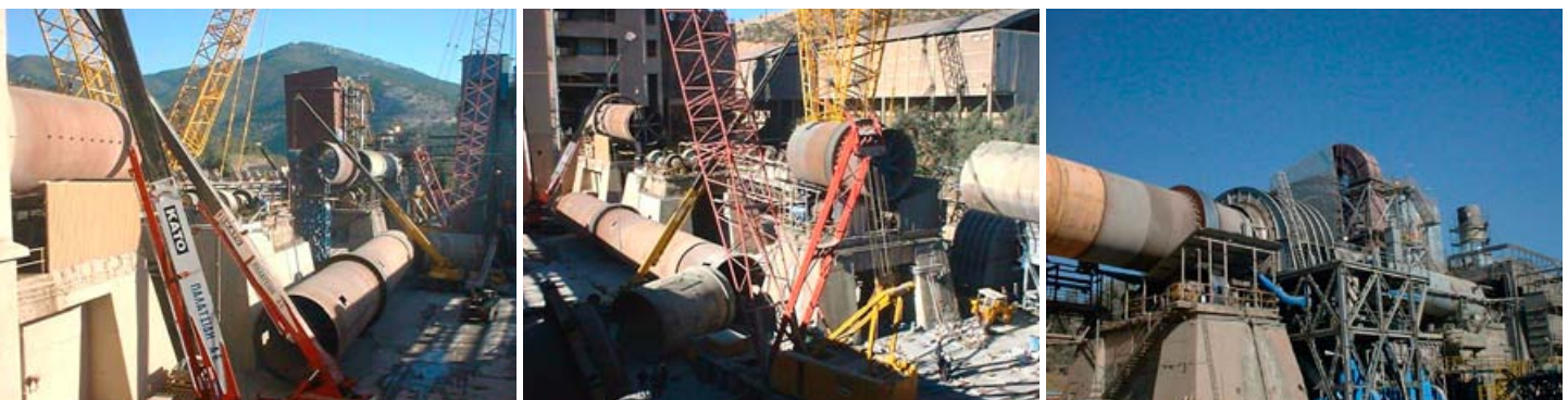
Ανακατασκευή του περιστροφικού κλιβάνου 1 με τοποθέτηση του ψύκτη εσχάρας κλίνκερ.
