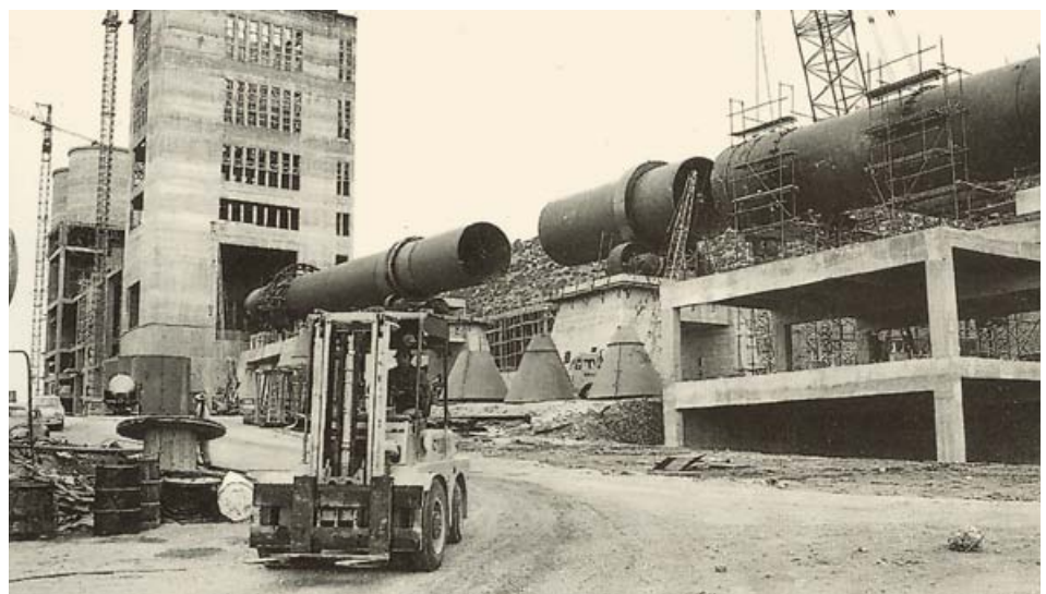
Συναρμολόγηση των τμημάτων του κλιβάνου της πρώτης μονάδας.
