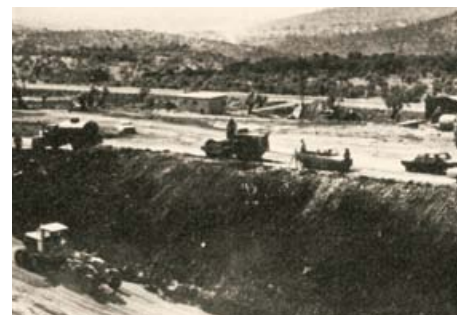
Οι εκσκαφές για την εξυγίανση του εδάφους και τη θεμελίωση του κλίβανου ήταν από τις πρώτες εργασίες.
