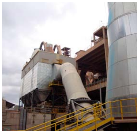
Για την περαιτέρω μείωση των εκπομπών σκόνης, το 2005 εγκαταστάθηκε το νέο σακκόφιλτρο του περιστροφικού κλιβάνου 1.
