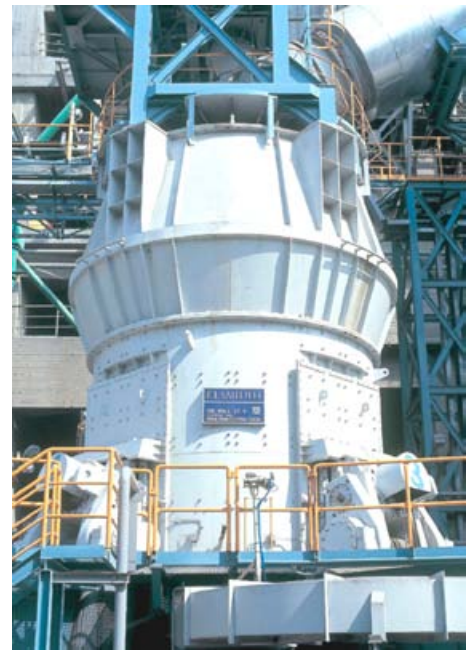
Εγκατάσταση κατακόρυφου μύλου άλεσης τσιμέντου (MT4) με στόχο την ενεργειακή αποδοτικότητά.
