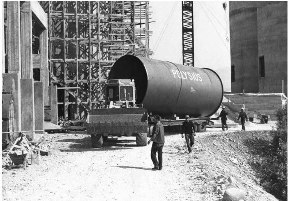
Μεταφορά τμήματος του περιστροφικού κλιβάνου.
