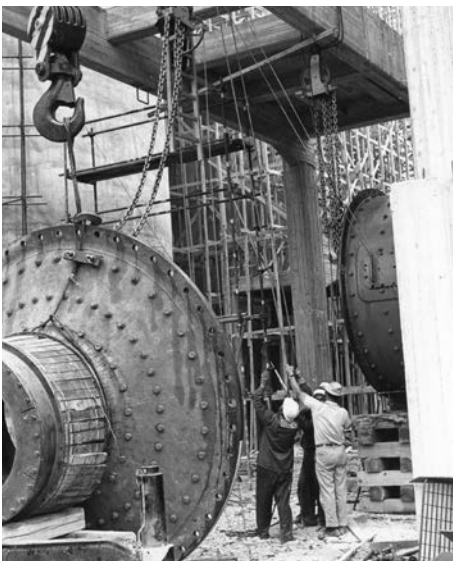
Συναρμολόγηση μύλου.
