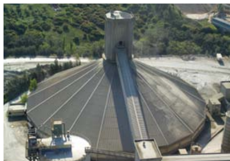
Το σύστημα αποτελείται από το κτίριο της κυκλικής αποθήκης, τα μηχανήματα αποκονίωσης και τα μεταφορικά μηχανήματα, που καλύπτουν μέρος αερογέφυρας άνω των 400μ.
