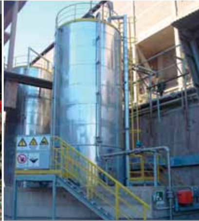
SNCR για τη μείωση των εκπομπών NO x
