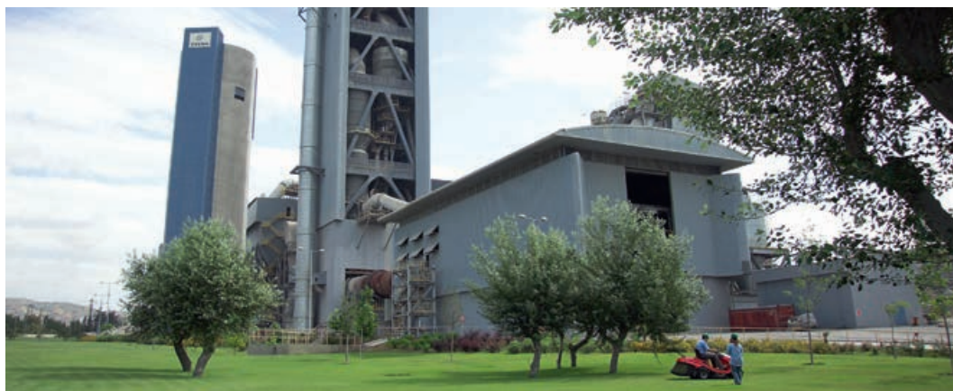
Άποψη του εργοστασίου Θεσσαλονίκης (2012).
