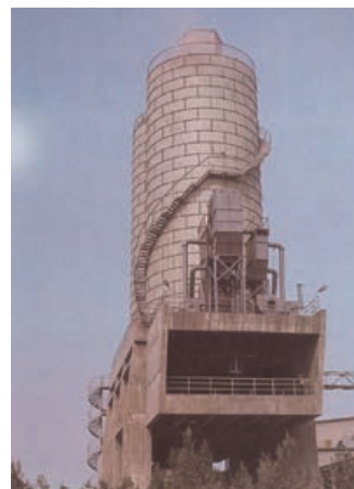
Ο Σταθμός Χύδην Τσιμέντου.
