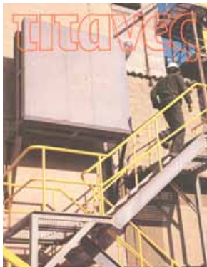
• Τεύχος 32 Φεβρουάριος - Μάρτιος 1985 Τοποθέτηση ηχοπαγίδων στο εργοστάσιο Δρεπάνου στο πλαίσιο εφαρμογής προγράμματος ηχοπροστασίας.
