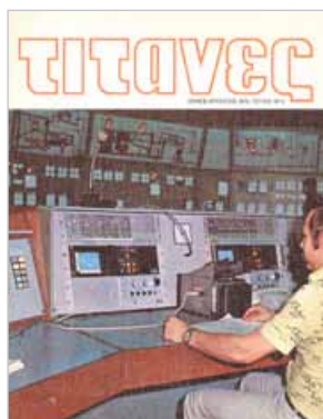
• Τεύχος 2 Ιούλιος - Αύγουστος 1979 Κεντρικός Πίνακας Χειρισμού εργοστασίου του Τιτάνα.
