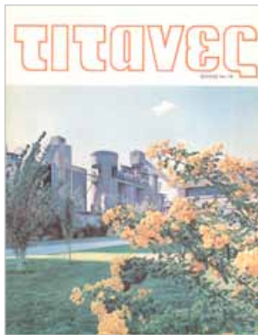
• Τεύχος 19 Σεπτέμβριος - Οκτώβριος 1982 Το εργοστάσιο στο Καμάρι βρίσκεται μέσα σ' έναν πραγματικό κήπο.
