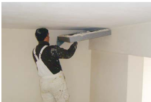
Επικόλληση θερμομονωτικών πλακών
