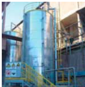
SNCR - Σύστημα Επιλεκτικής Μη Καταλυτικής Αναγωγής για τη μείωση των εκπομπών NO x
