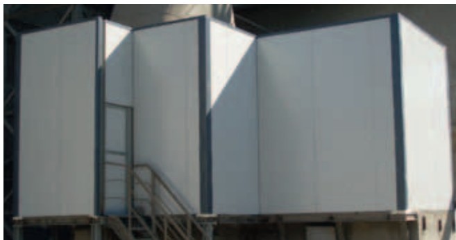
Ηχοπέτασμα σε μύλο ταϊμέντου για τη μείωση πρόκλησης θορύβου
