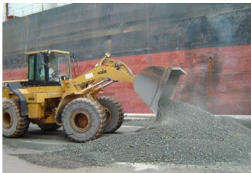
Διαμόρφωση σωρού με φορτωτή
