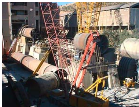
Ανακατασκευή του περιστροφικού κλιβάνου 1 με τοποθέτηση του ψύκτη εσχάρας κλίνκερ.
