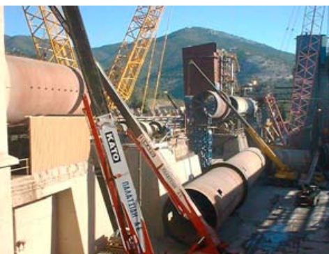
Ανακατασκευή του περιστροφικού κλιβάνου 1 με τοποθέτηση του ψύκτη εσχάρας κλίνκερ.
