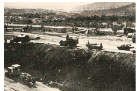
Οι εκσκαφές για την εξυγίανση του εδάφους και τη θεμελίωση του κλίβανου ήταν από τις πρώτες εργασίες.
